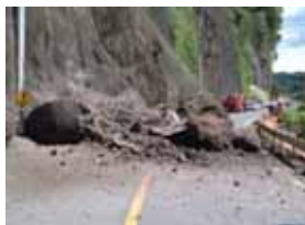
国道353号斜面崩落
