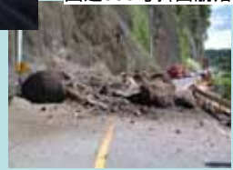
国道353号斜面崩落
