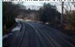
県道渋川東吾妻線冬期状況
